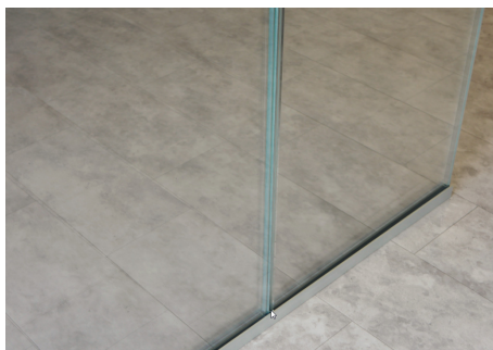
Vertikale Glasabstandhalter, horizontale Abstandhalterprofile in Schwarz oder Grau
