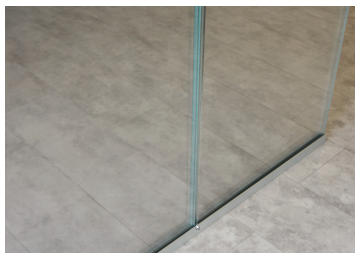
Entretoises verticales en verre, profils intercalaires horizontaux en noir ou gris
