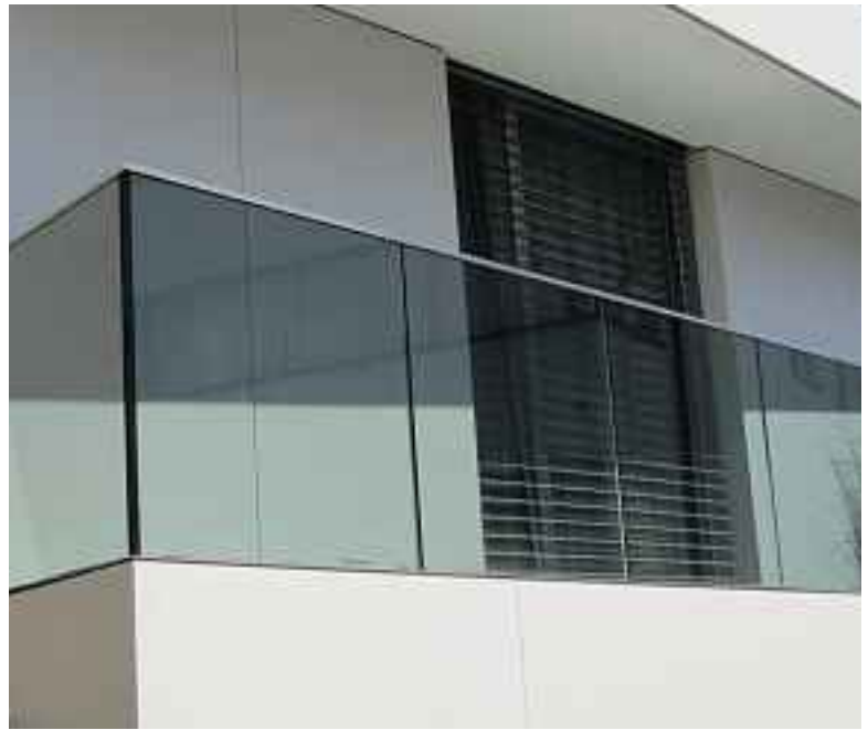
Überbauung Post, Willisau
