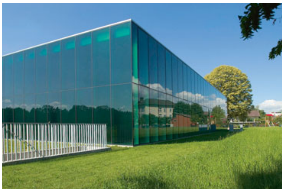
Scuola a Rohr
