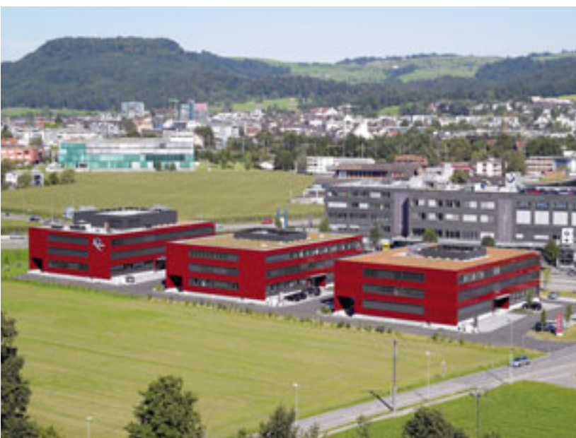
Edificio per uffici e aziende IMPULS, Baar Architetto: Jego AG
