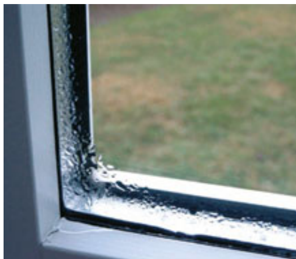
Condensa nella zona dei bordi della lastra interna
