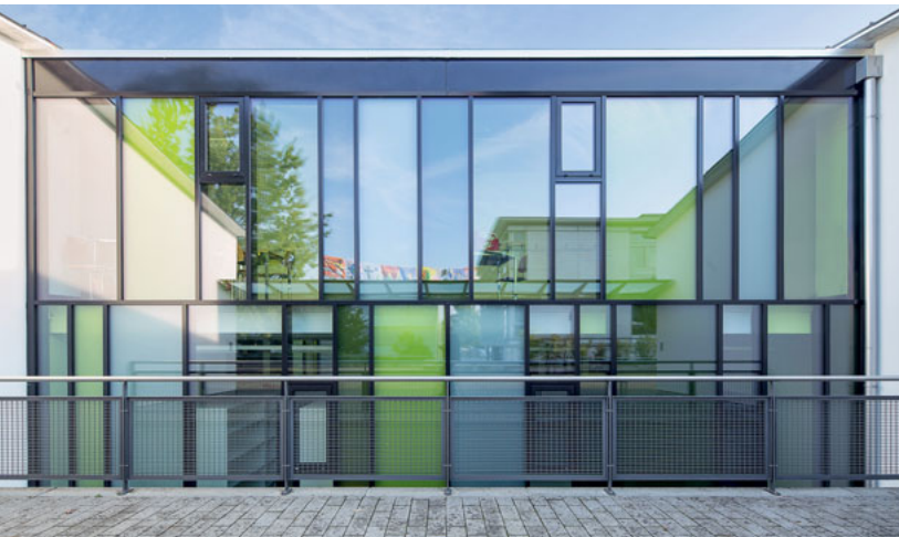
Groupe scolaire Waldegg, Rotkreuz © ARCHITEKTURFABRIK, Architekten ETH HTL SIA, Affoltern a.A.
