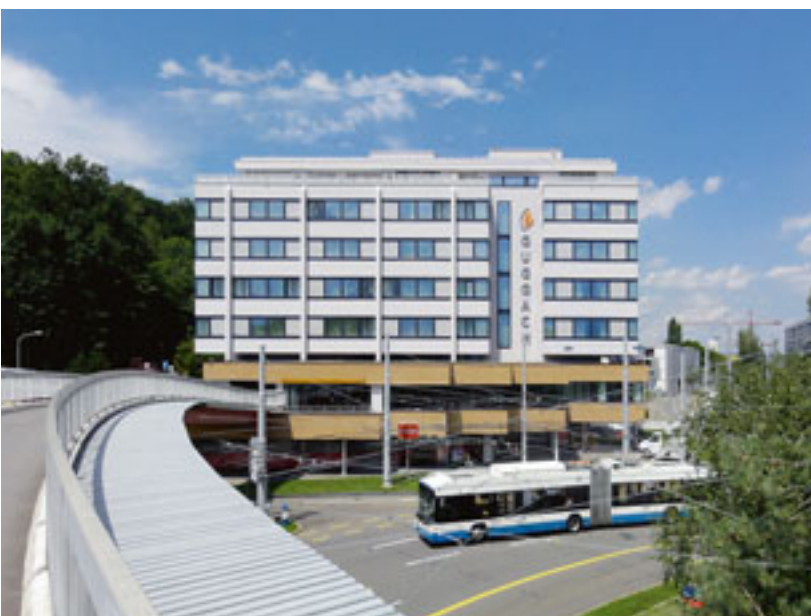
Hotel Guggach, Zürich Bild: mépp ag, Zürich
