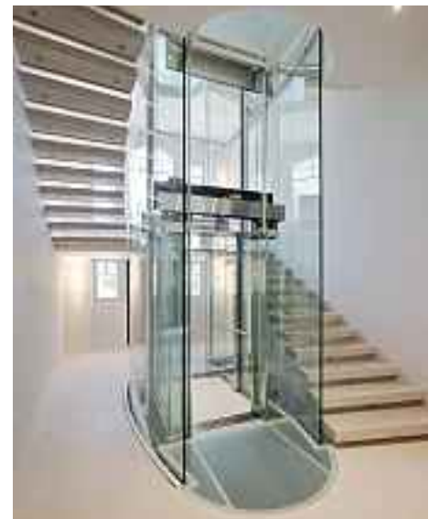
Liftverkleidung
