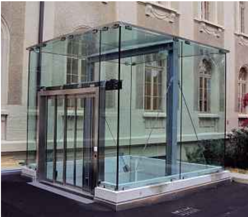
Liftschachtverkleidung
