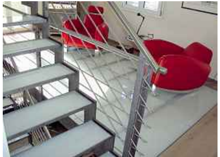
Glasboden und Glastreppentritte, Einfamilienhaus
